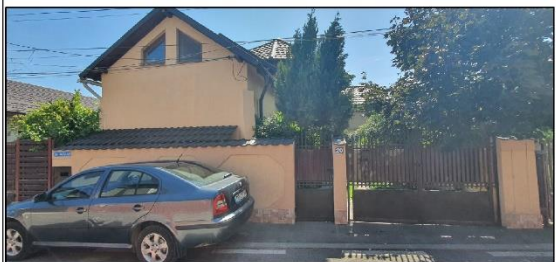
Clădiri în vecinătate
