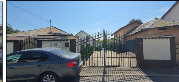
Clădiri în vecinătate
