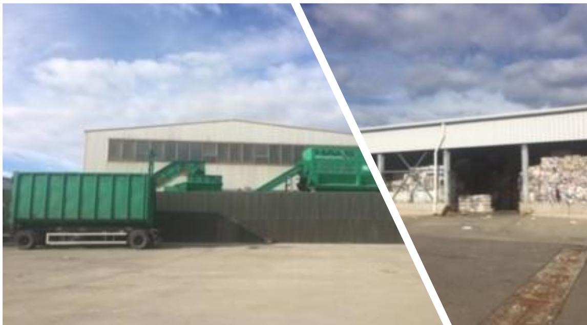
Figura 1-1: Stația de sortare Aninoasa
