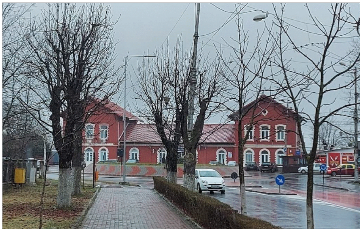
Figura 2.81. Stația de cale ferată Târgoviște.
