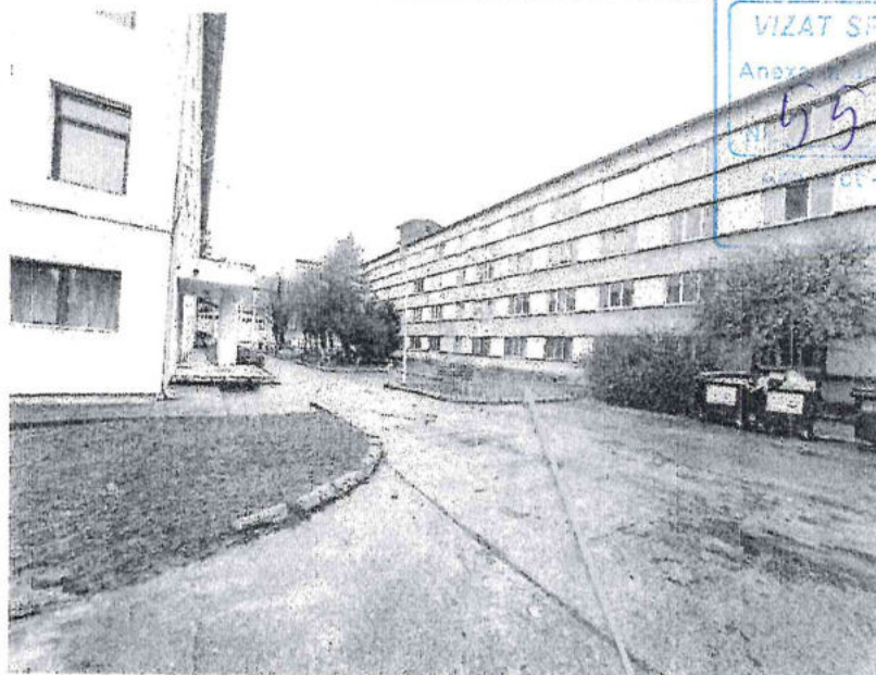
Foto nr. 2-vedere amplasament F 2
