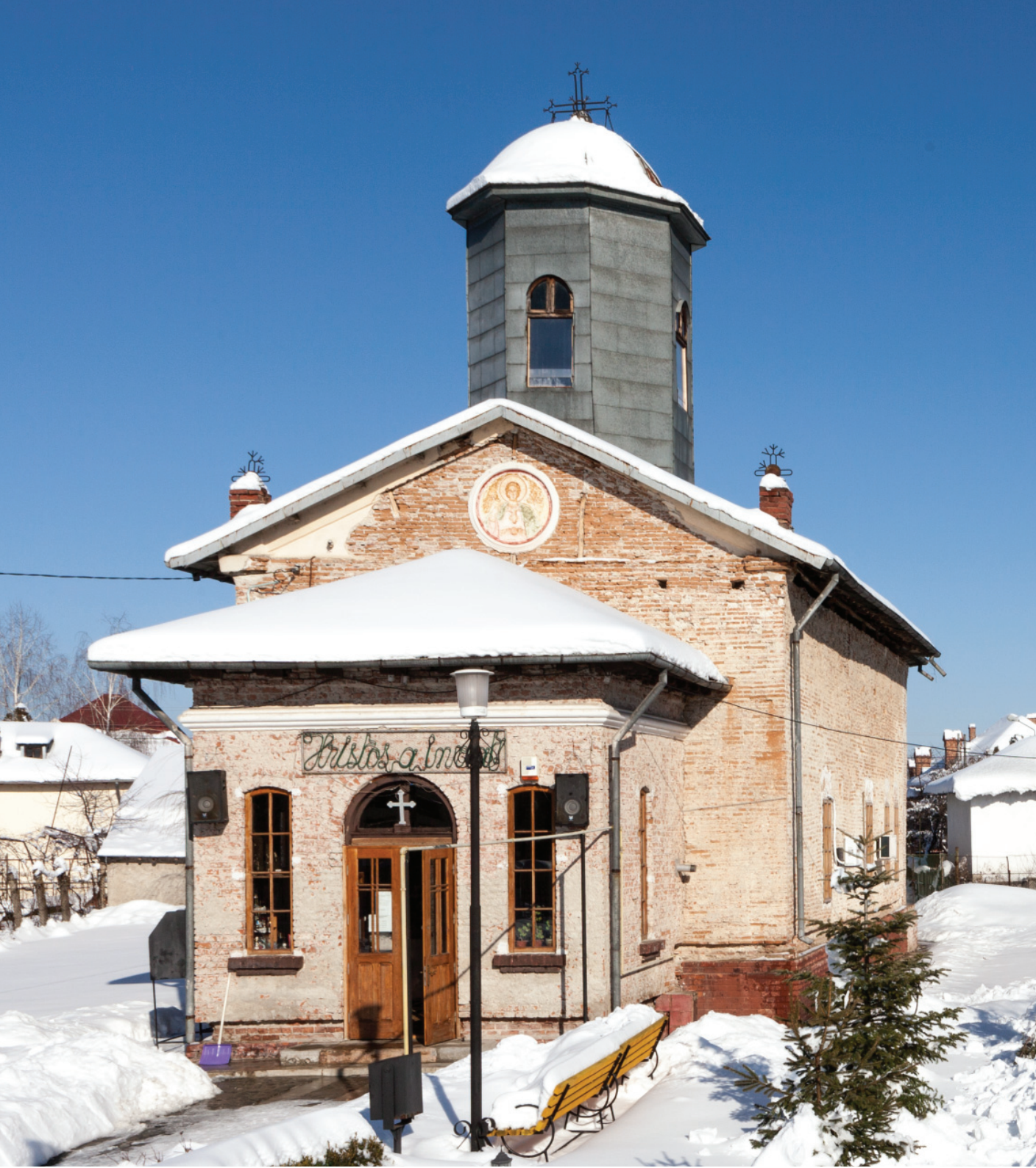
Biserica Sf. Dumitru - Buzinca. Vedere a fațadei vestice.
